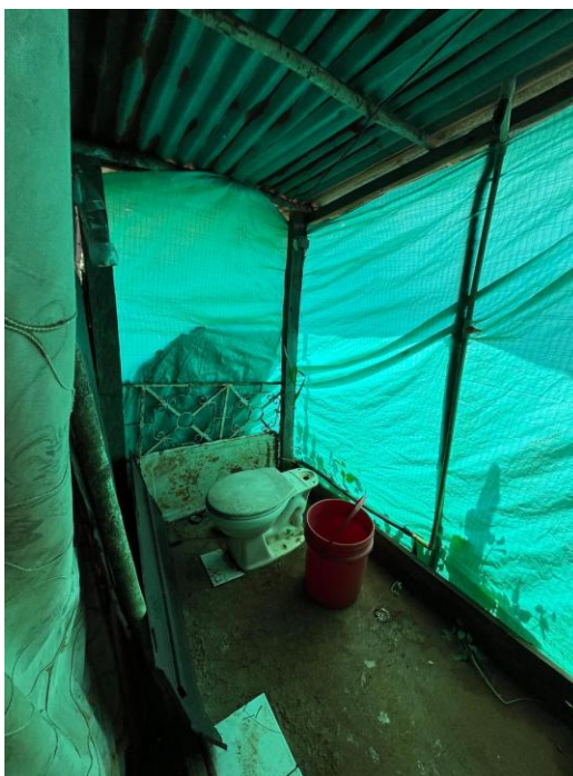
Fotografía 4. El baño como se puede evidenciar en la ilustración anterior se encuentra encerrado en plástico y lona, piso en tierra pisada no cuenta con ducha.
