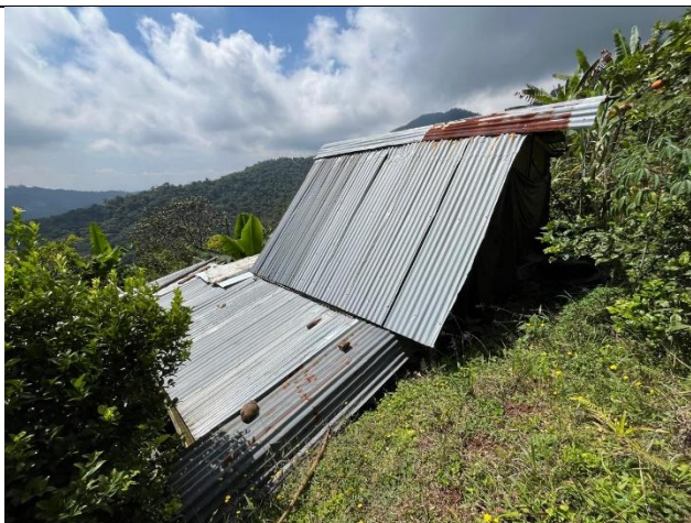
Fotografía 3. La cubierta que cubre la infraestructura se encuentra una parte deteriorada por la corrosión, algunas de estas laminas no se encuentran sujetadas.
